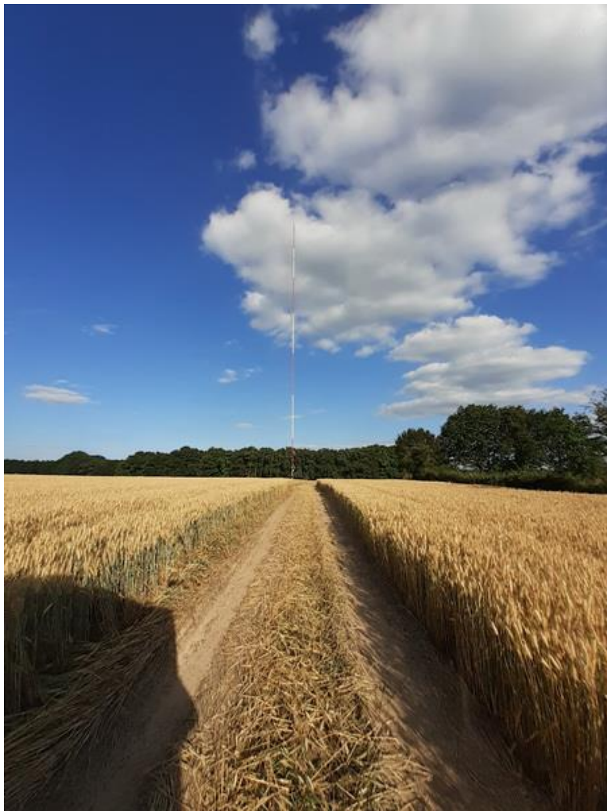
Illustration 6 : Mât de mesure installé sur la commune de Cirières (79)
